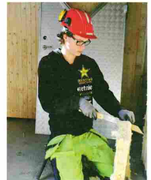
Arbete pågår. Kevin Moberg skär till isoleringen som ska användas inne i bastun.
